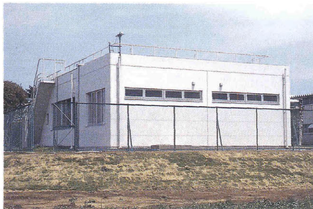
写真1 増築された微細気象観測棟 (正面内部に温室効果ガス分析装置が新設された)
