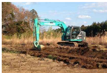
図1 バックホーによる表土削り取り作業
