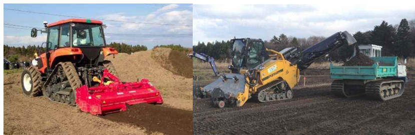
図4 開発機と建設用機械との連携作業
