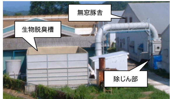
図4 無窓豚舎に設置した生物脱臭方式の開発機
