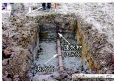
写真1 水田の排水を改善する暗渠 (土中に埋設された暗渠を掘り起こした様子)
