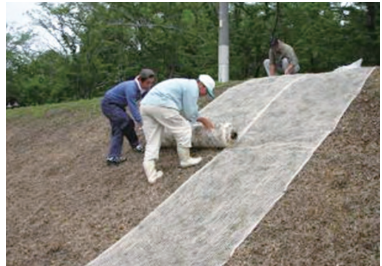
写真1 二重ネット工法による畦畔法面におけるシバの植栽
