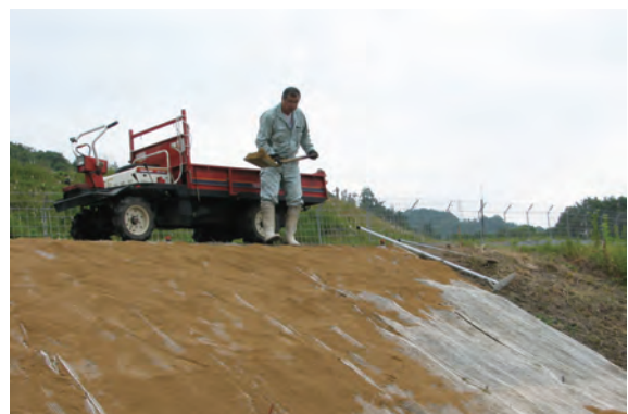
写真2 二重ネット工法で施工、覆土作業中。
