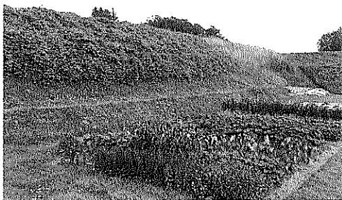
Photo 19 復旧工事後8年目のNo.2法面
