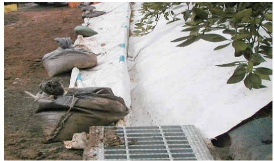
簡易排水溝の構造（左）と設置した簡易排水溝（右）
