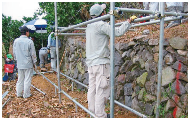
図2 スロープ設置作業の様子
