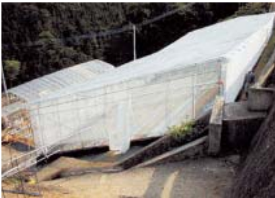
写真1 平張型傾斜ハウス
