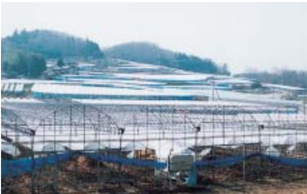
新見市豊永国寄地区のビニル被覆後の風景
