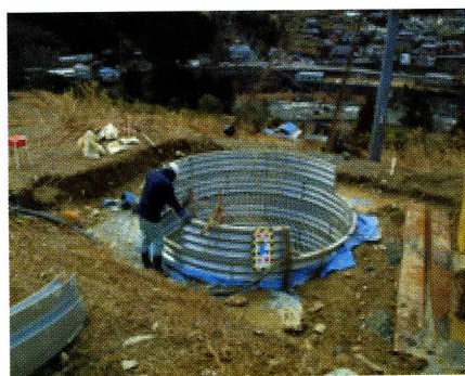
写真1 地すべり地帯での集水井設置
