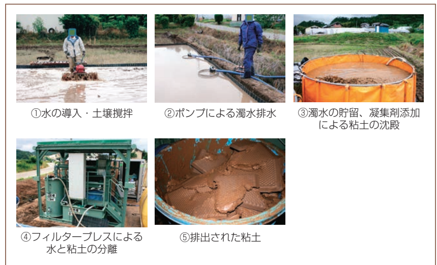
写真/水による土壌攪拌・除去技術による放射性セシウム浄化工程
