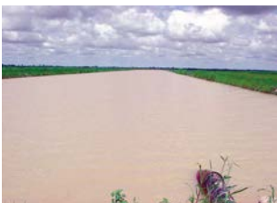
写真3：水稲栽培用の深井戸水の溜池
