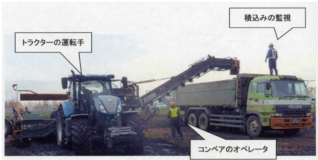
写真 12 移動式除土積込機の監視作業（パンフレット）
