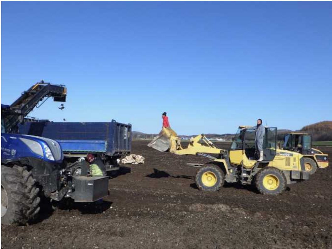
写真 11 移動式除土積込機の監視作業（実証試験）
