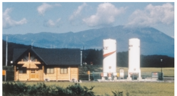
写真2：岩手山を背景に、液化炭酸ガス貯蔵タンクと観測施設
