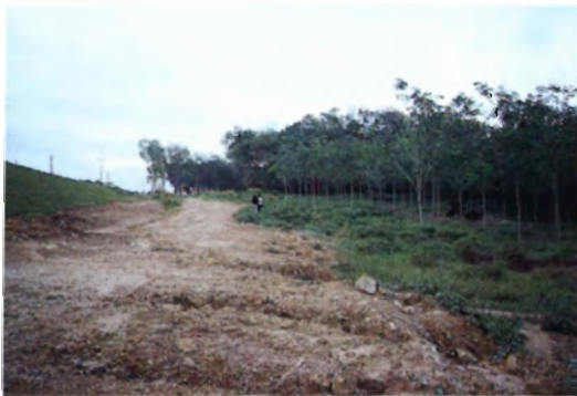
水路建設(左)によって攪乱され たゴムプランテーションの縁に自生する V. trinervia (ペラ州, 93507地点)
