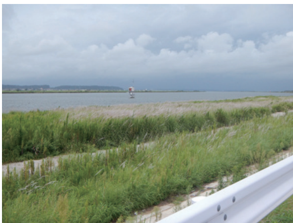
Photo 5. A habitat of S.spontaneum around Hitachigawa Ohashi Bridge in Kamisu City (JW786) 写真 5. 常陸川大橋付近 (神栖市) における自生状況
