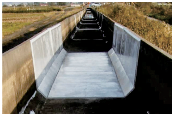
Fig. 1 局所的な補修により補修/未補修区間が混在した事例 Case of intermittent repairing mixed repaired / unrepaired sections
