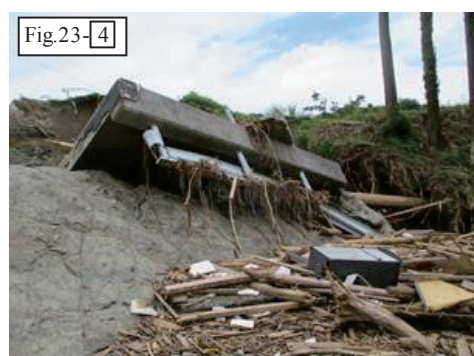
Fig. 27 崩壊した洪水吐上部の道路橋 Collapsed road bridge on spillway
