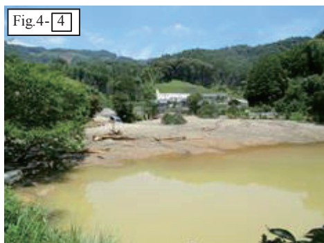
Fig. 8 梅川内ため池内の堆砂状況 貯水池右岸から土砂流入の様子 Sand and mud flowed into Umegochi pond
