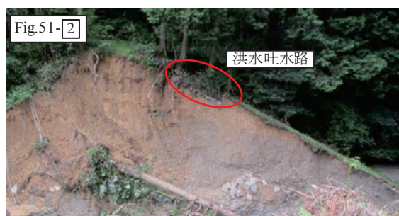
Fig. 53 洪水吐の崩壊 Failure of spillway
