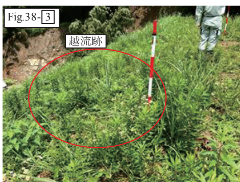
Fig. 41 堤体下流法面の越流跡 草木が越流によって倒されている Trace of flood at downstream slope of bank Vegetation has been washed away by flood
