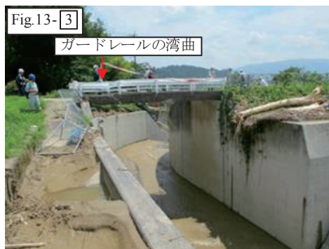
Fig. 16 洪水吐水路上部の道路橋のガードレール 流木の激突によって湾曲している Guardrail of road bridge on spillway channel
