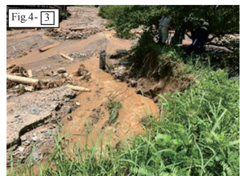
Fig. 7 梅川内ため池堤体の崩壊部 寒水川の氾濫によって堤体が崩壊している Failure part at Umegochi pond
