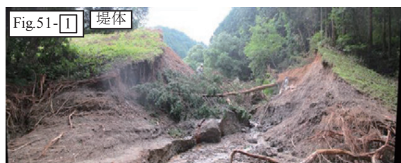
Fig. 52 吉ヶ谷ため池堤体の決壊 Collapsed bank of Yoshigatani pond
