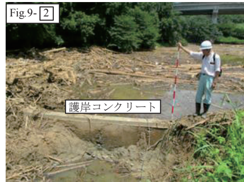
Fig. 11 崩壊した上野ため池の右岸 堤体が崩壊し護岸コンクリートのみ存置 Right side at collapsed Ueno pond
