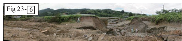
Fig. 29 決壊した山の神 2 ため池の堤体 Collapsed bank of Yamanokami 2 pond
