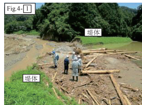
Fig. 5 梅川内2ため池の堤体崩壊部 寒水川からの侵食で堤体が流失している Failure part at Umegochi 2 pond
