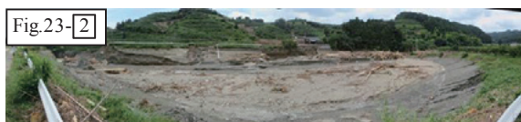
Fig. 25 山の神ため池内の堆砂状況 Sand and mud flowed into Yamanokami pond
