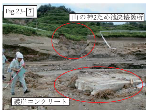
Fig. 30 護岸コンクリートの崩落 Failure of concrete revetment
