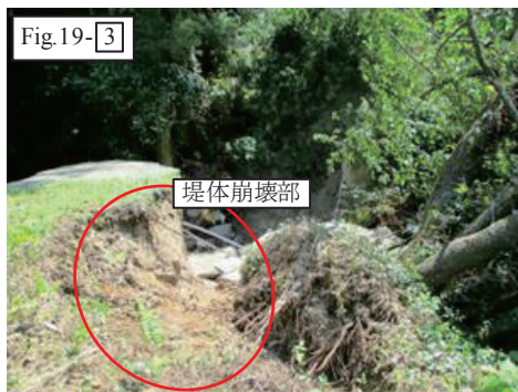
Fig. 22 崩壊した堤体右岸 Collapsed right side bank
