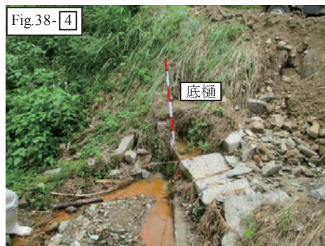
Fig. 42 土砂で詰まった底樋 Outlet conduit filled by sand
