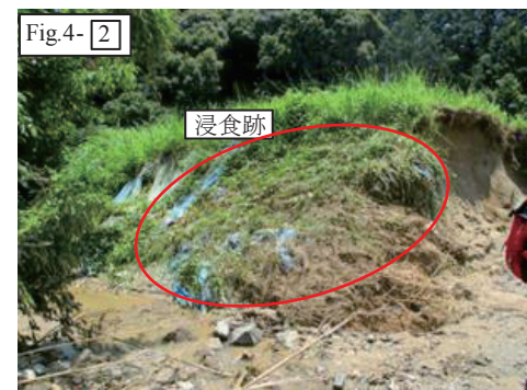
Fig. 6 梅川内2ため池の下流斜面 Downstream slope at at Umegochi 2 pond
