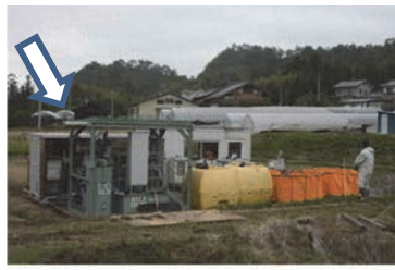
⑤ 加圧ろ過装置(写真矢印の装置)による水と粘土の分離
