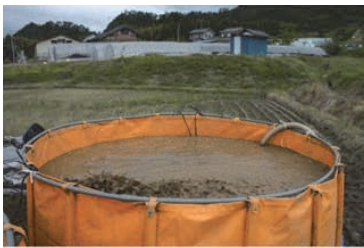
④ 濁水の貯留、凝集剤添加による粘土の沈殿
