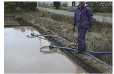
③ ポンプによる濁水の排水
