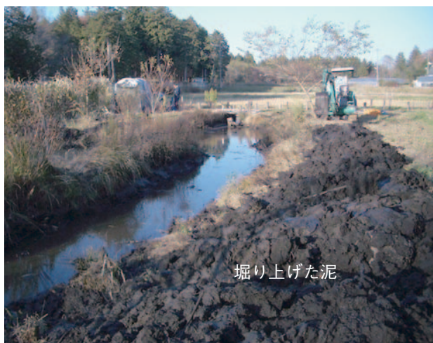
写真IV-1 2008年12月に行った浚渫後の水路の様子と掘り上げた泥
