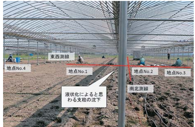
第1図 地震発生後支柱が沈下した野菜栽培施設（熊本市）での地下部調査における測線位置
