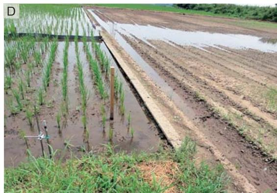
写真7 地震による農道、水路、畦畔の損壊
