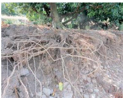
写真2 石垣崩落による根の露出割合が6割の樹の状況(2016年8月4日)
