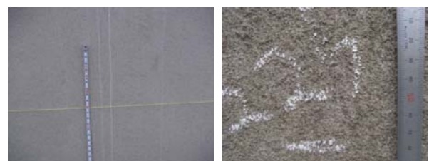
(a)補修施工直後の水路側壁 (b)補修後供用中の水路側壁 Fig. 70 補修材の表面状況
