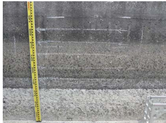
Fig. 18 D 地区の状況 Canal state in the D district
