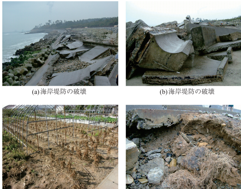
(a) 海岸堤防の破壊 (b) 海岸堤防の破壊 (c) 海水の浸水による塩害 (d) 海岸堤防裏法の吸出し状況
