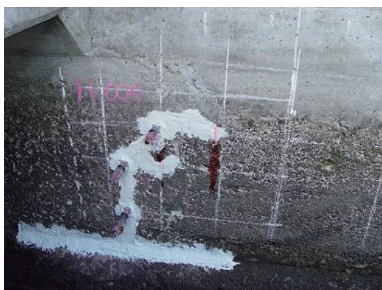
Fig.5-1 注入工法によるひび割れ補修の例 Example of grouting into cracks
