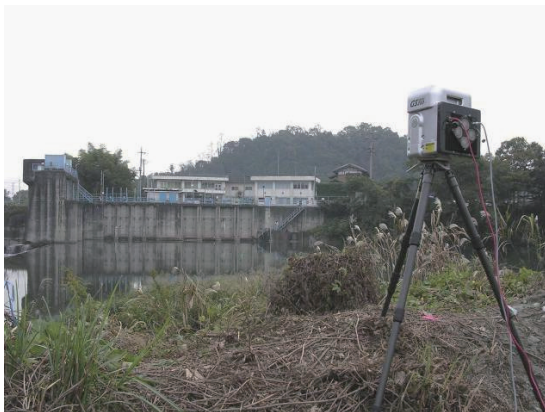
Fig.3-13 3次元レーザースキャナーによる計測状況 Measurement of a structure using 3D digital laser scanner
