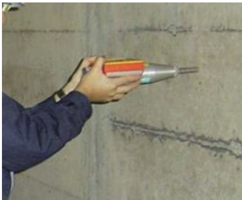
Fig.3-3 リバウンドハンマーによるコンクリート圧縮強度の測定 Measurement of concrete compression strength by rebound hammer
