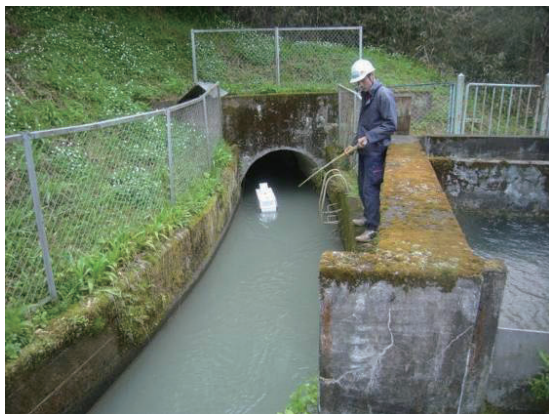
Fig.3-18 トンネルでの現地実証試験の状況 Onsite survey
