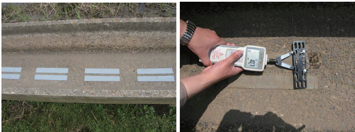
(a) 水路底版に施工したシーリング材
