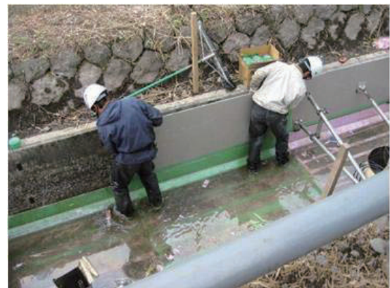
Fig.5-5 レジンコンクリートパネル工法の施工状況 Irrigation canal repairing by resin concrete panel lining method
