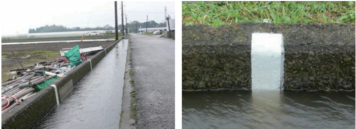
Fig.5-27 目地補修から2年4ヵ月後の状況
