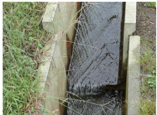
Fig.2-33 二次製品水路における躯体のずれ Gap of a precast concrete canal
