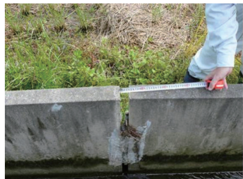
Fig.2-15 地震により目地部が大きく開いた状態 Opening of canal joint by earthquake
