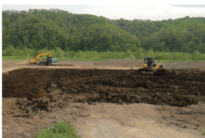
Fig. 5 区画整備による表土扱い工法 Topsoil handling method by field division improvement
