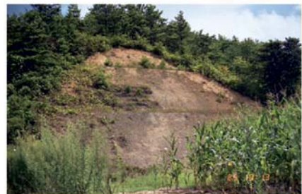
施工4年後 1989年8月
