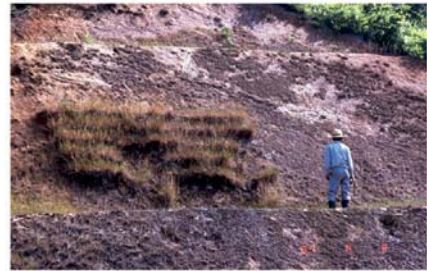
施工2年後 1987年7月
