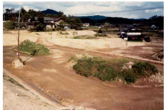
調査耕区の下側隣接区、一般には1耕区の「置き土」は1カ所
