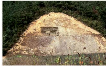
施工1年後 1986年10月
