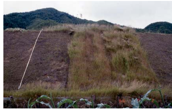
左からバーク区、混合区、化成区(切土)
