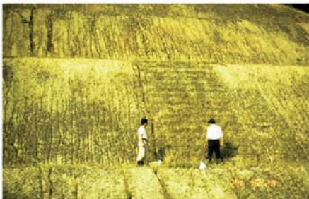
施工10年後 1995年9月
