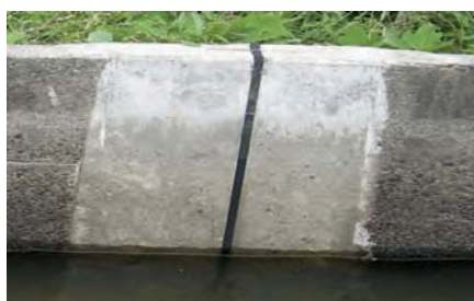
補修された継目
