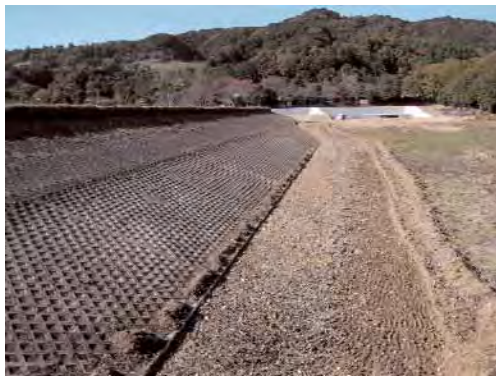
Photo.1 補強工事実施前の堤体の状況
