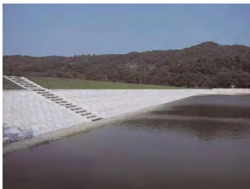
Photo.2 補強工事実施後の堤体の状況
