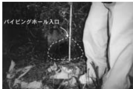
Photo 3-18 柳ため池のバイピングホール入口 Entrance of piping hall of Yanagi dam
