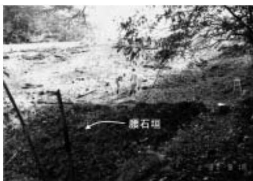
Photo 3-15 田の方上ため池（下流側より堤体を望む） Tanokatakami dam (viewed from downstream)
