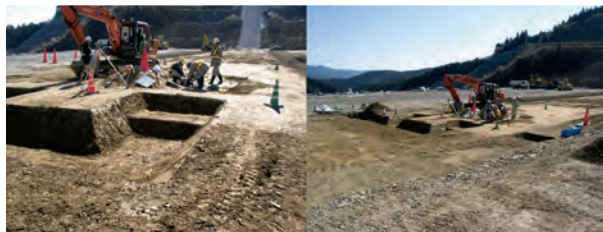
Fig.4 ケーブルトレンチおよび間隙水圧計設置位置の概観 Views of cable trench and the location for the transducers
