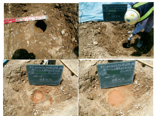
Fig.17 コアにおけるワイヤレス間隙水圧計の設置状況 Views of setting up the wireless transducer in core zone
