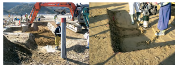
Fig.7 ケーブルトレンチの埋め戻し状況 Views of burying the cable trench
