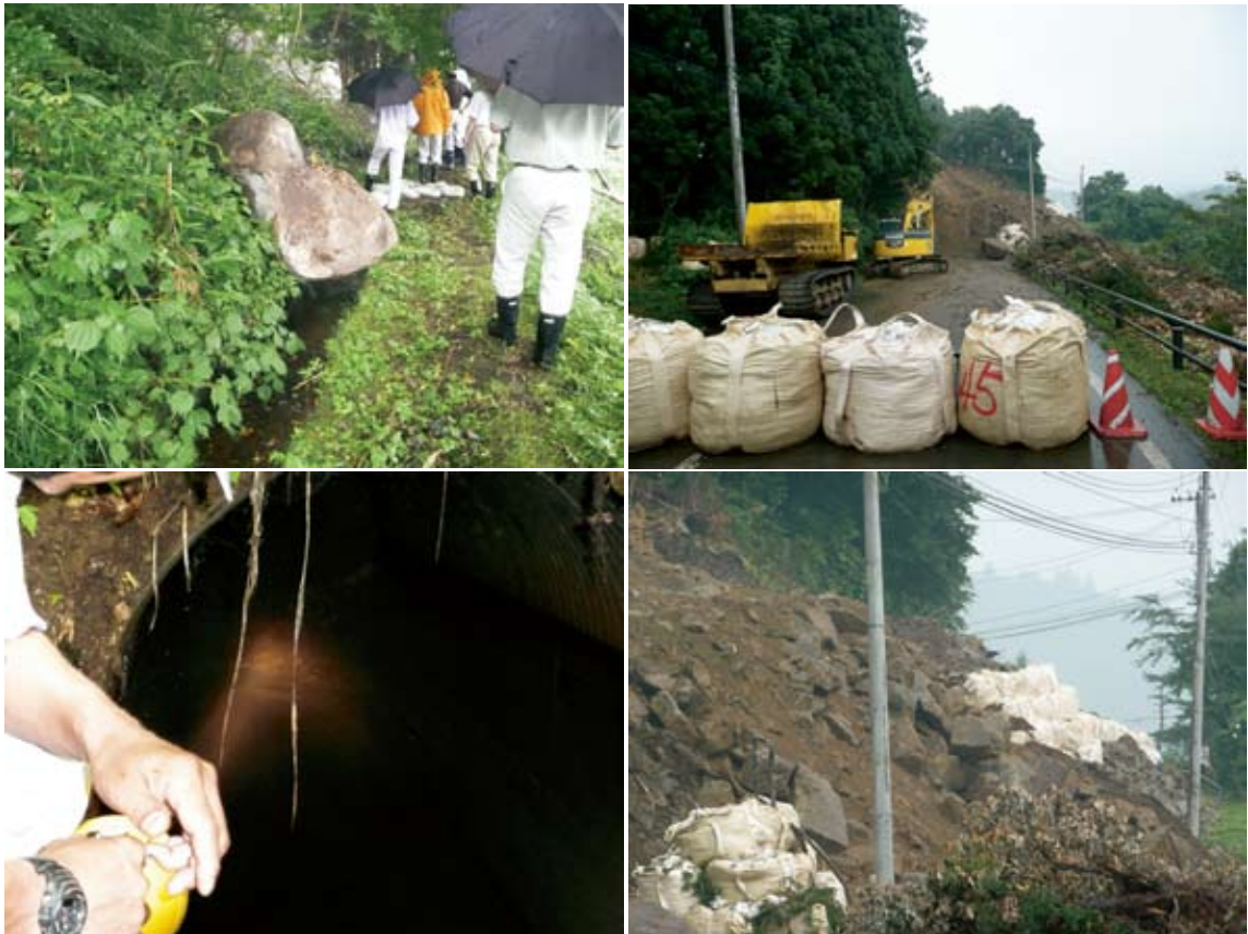
Fig.14 下真坂用水 1 号トンネルの被災（左上：トンネル上流開水路への転石（Fig.12, ①地点）， 左下：トンネル出口付近の堆積土（Fig.12, ③地点），右：トンネル上部の斜面崩壊（Fig.12, ②地点） Damages of Shimo-masaka channel tunnel No.1 (upper left :fallen rocks in the Shimo masaka upstream channel, lower left :deposited soil at the outlet of the tunnel, right :slope collapse over the inlet of the tunnel)
