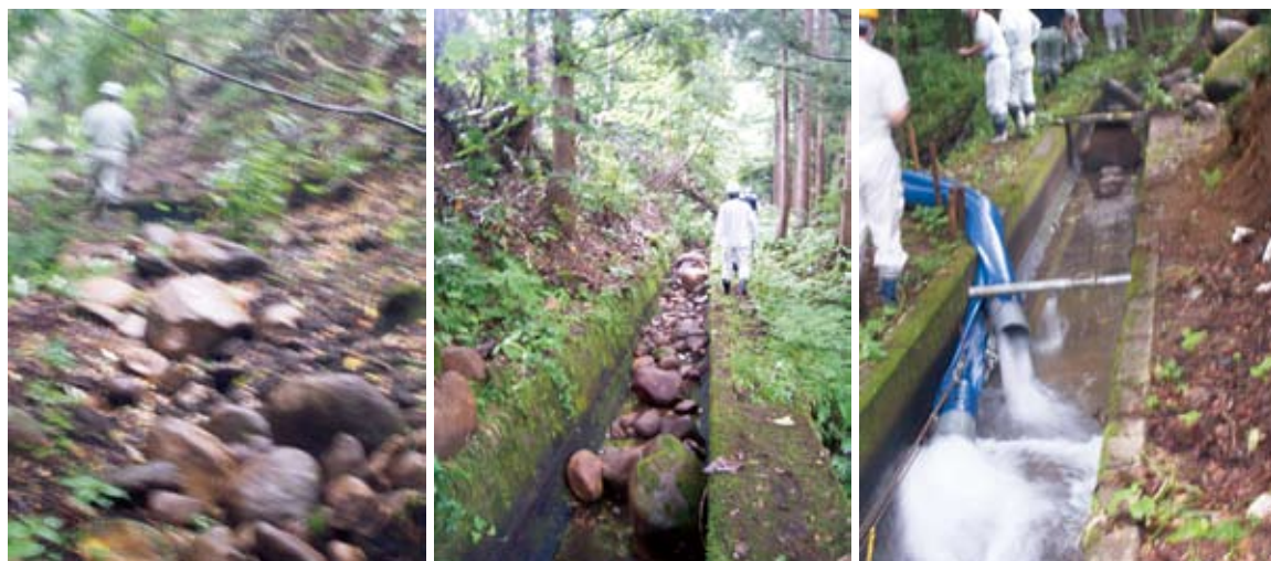
Fig.11 大原堰用水路の開水路グレーチング上への落石状況（左），開水路への落石状況（中）， 仮設ポンプから開水路への放水状況（右）（ Fig.7 ，③地点）
