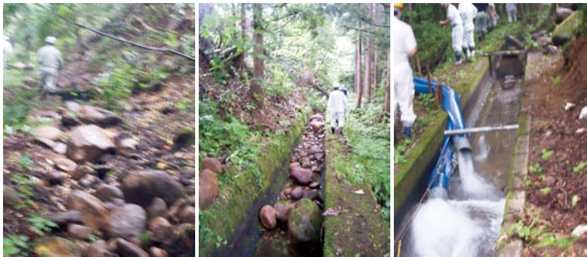
Fig.11 大原堰用水路の開水路グレーティング上への落石状況（左），開水路への落石状況（中）， 仮設ポンプから開水路への放水状況（右）（Fig.7，③地点）
