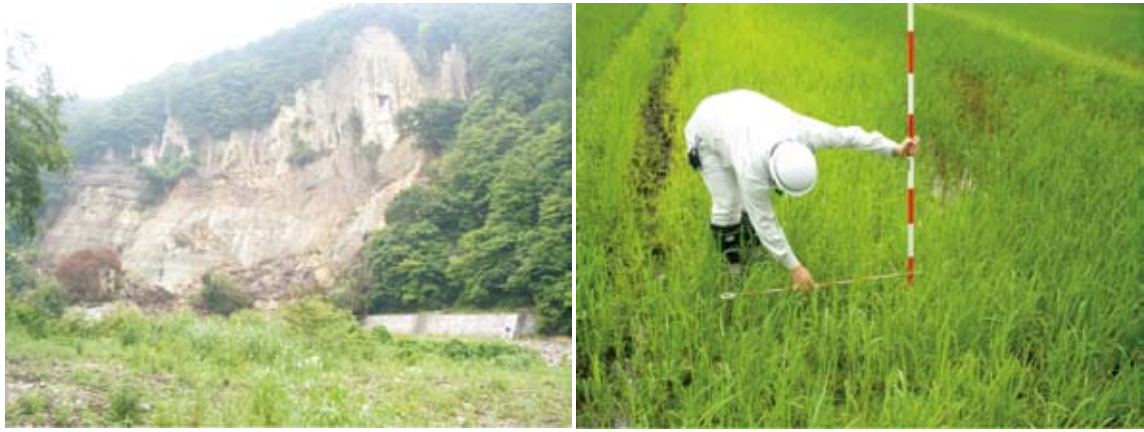
Fig.18 さがりまつ 下り松用水の斜面崩落状況（左）、水田の地盤沈下（右、 はのきだて 楓木立地区） The slope collapse on the Sagirimatsu channel (left), a subsidence in a paddy field at Hanokidate district (right)
