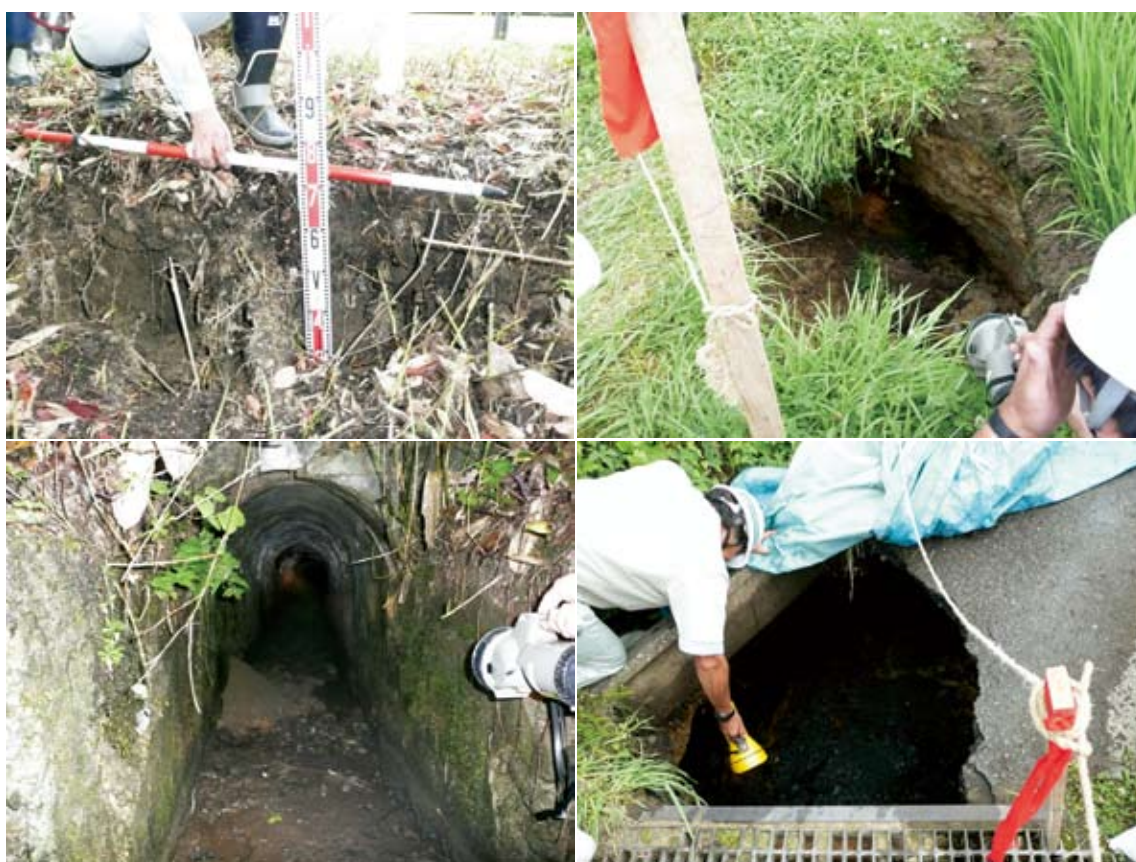
Fig.17 下真坂用水 3 号トンネルの被災 (左上: トンネル入り口上部の地盤沈下による段差 (Fig.12, ⑥地点), 左下: トンネル入り口付近の土砂崩落, 右上: トンネル出口 (Fig.12, ⑦地点) 直上流上部の地盤の陥没 (約2m深さの亀裂), 右下: トンネル出口付近の地盤の陥没)
