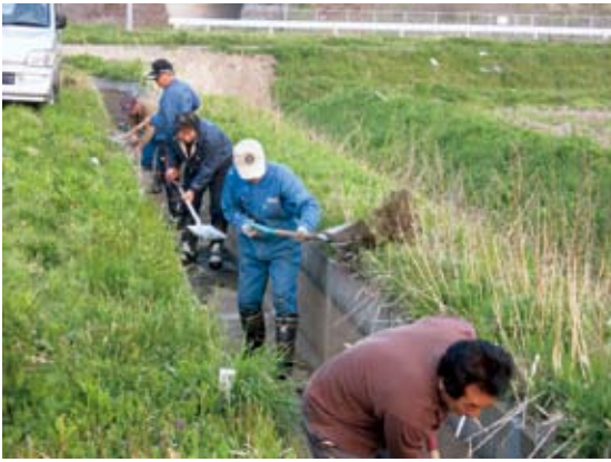
Fig.1 農地・水・環境保全向上対策による水路の泥上げ (高槻地域みどり会, 山形県)
