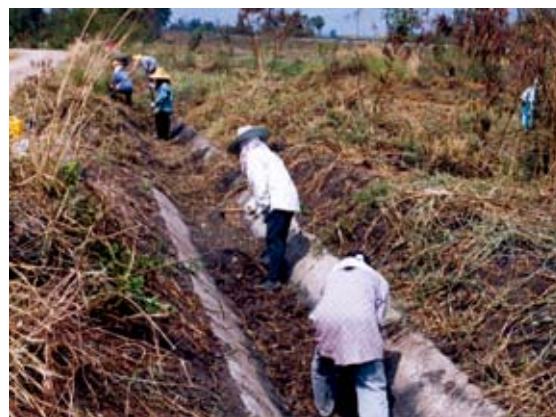
Fig.2 PIM 実現を支援する日本の技術協力プロジェクトによる 水路の泥上げ (水管理システム近代化計画, タイ国)
