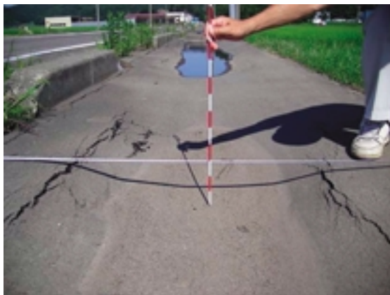
Fig.14 埋戻し部分に沿って生じた歩道での路面沈下 Settlement of sidewalk
