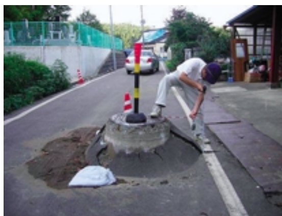
Fig.21 マンホールの浮上 Uplift of a manhole
