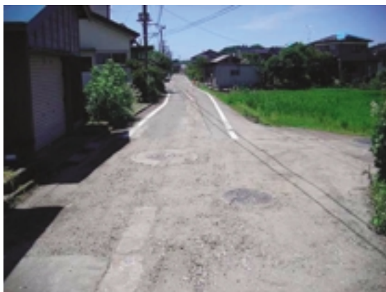
Fig.9 手前は通常の砂で埋戻されている区間、奥は改良土で埋戻されている区間。改良土区間では地表面の変位はほとんど見られない。
