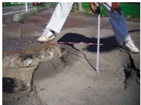
Fig.17 歩道でのマンホールの浮上 Uplift of a sidewalk manhole
