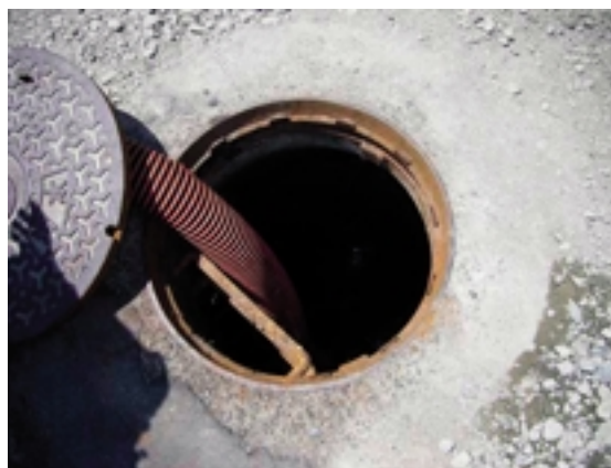
Fig.11 バキュームカーによる汚水の吸引 Sewage being vacuumed into a honey wagon
