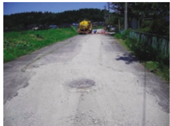
Fig.7 沈下した路面部分に敷均された碎石 Crushed stone used as fill after settlement of road
