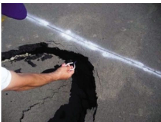
Fig.19 アスファルトの下部に発生した空洞 Hollow under asphalt
