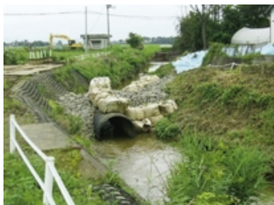
Fig.3 コルゲート管による応急措置状況 Use of corrugated pipe for urgent canal repair
