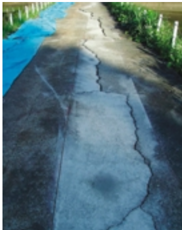
Fig.47 天端コンクリートの堤軸方向亀裂(上池) Along-axis cracks in concrete pavement on a dam crest
