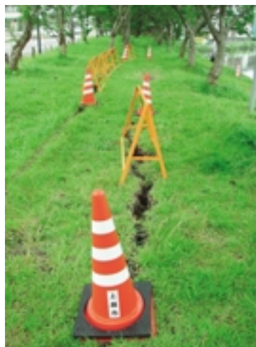
Fig.41 天端の亀裂（坂田池） Cracks in a dam crest
