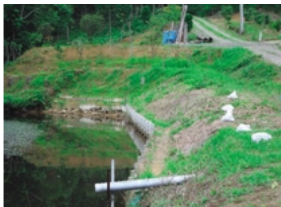
Fig.7 柵板の変形（渡内の池） Damage to upstream protection wall
