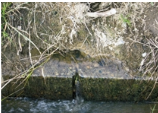
Fig.39 下流法先の漏水状況（東大池） Seepage at a down stream slope
