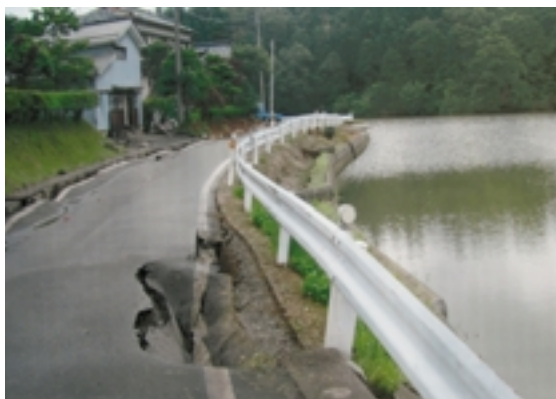
Fig.37 北側堤体（市道）の被害状況（東大池） Damage to a road around an earth dam
