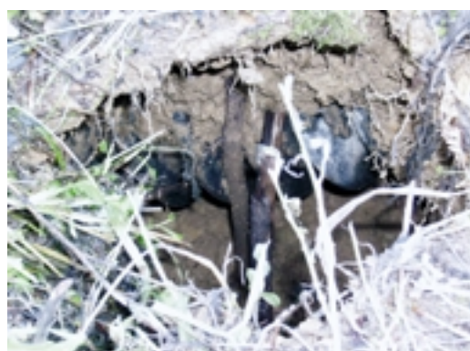
Fig.45 底樋周りの空隙（青野池） Space opened blow a conduit
