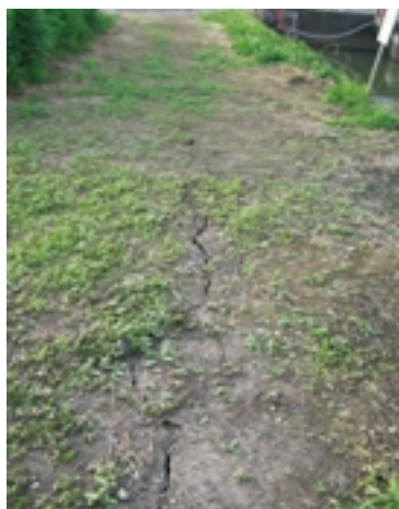
Fig.38 天端の亀裂（東大池） Crack on top of an embankment
