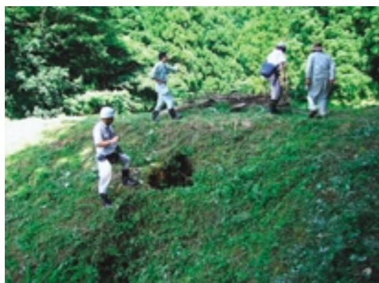
Fig.19 パイピングによる堤体土の流失（淀ヶ入池） Failure of piping and subsequent erosion
