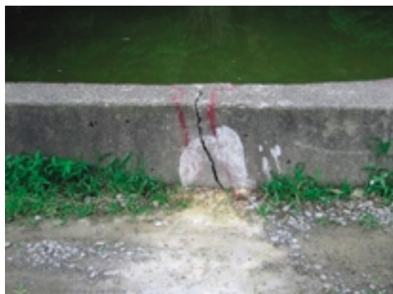
Fig.4 保護ブロックコンクリートの亀裂(荒屋の堤) Crack in up stream concrete block
