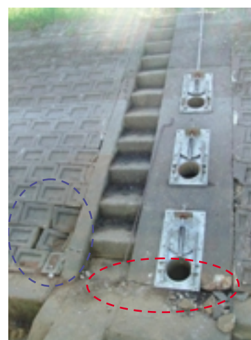
Fig.46 斜樋と張ブロックの被害（下池） Damages to an inclined conduit and concrete blocks
