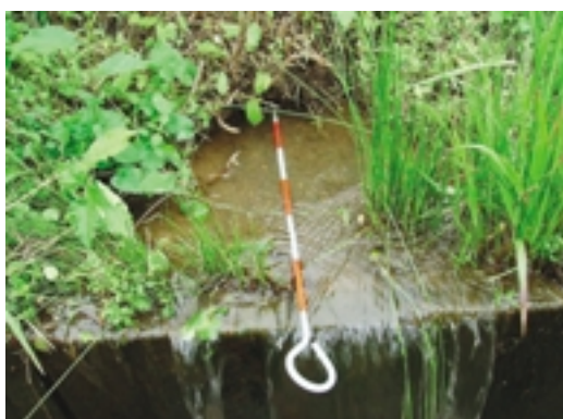
Fig.43 法尻の孔からの漏水（天ヶ池） Leakage from a hole at the toe of a downstream slope
