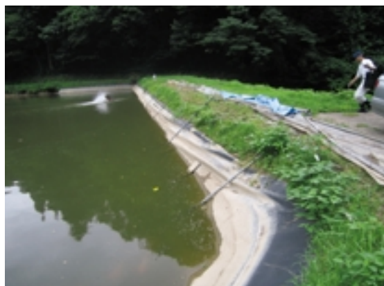
Fig.35 上流斜面の全景（柳沢新池） Damage to upstream slope
