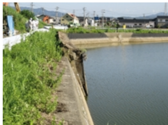
Fig.49 護岸コンクリート壁の被害(桐の木谷池) Damage to a concrete revetment wall
