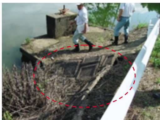
Fig.44 張ブロックの変形（青野池） Damage to concrete blocks
