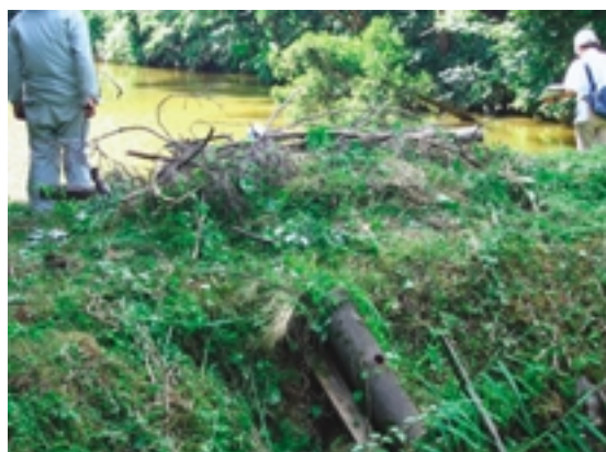
Fig.18 斜樋の損傷（淀ヶ入池） Damage to inlet works
