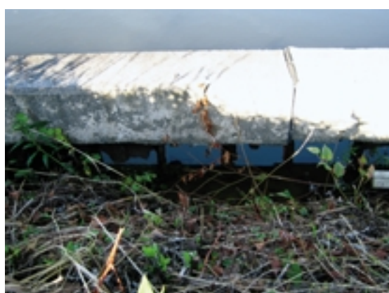
Fig.26 池堤体部の軽量矢板護岸の損傷（鬼王池） Damage to sheet pile wall
