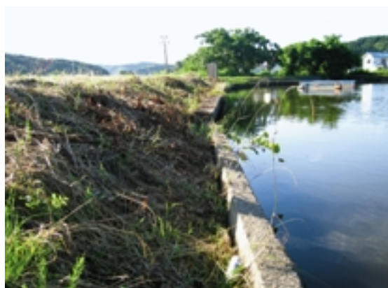
Fig.27 上流法面の変状（鬼王池） Deformation of upstream slope
