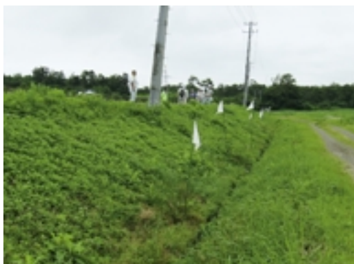
Fig.42 法尻部の漏水箇所（白旗が立っている地点，天ヶ池） Leaking points at the toe of a downstream slope
