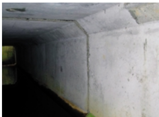
Fig.8 余水吐のボックスカルバート（目地部の段差、渡内の池） Spillway culvert (no damage)
