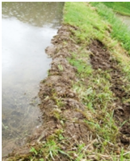
Fig.1 高上げにより補修された畦畔 Maintained dike by banking
