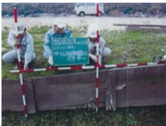
Fig. 35 水路縦断方向への変状 (石川県提供資料) Longitudinal deformation of canal at section B
