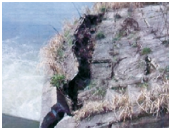
Fig. 16 コンクリート擁壁の倒壊 （被災当初：石川県提供資料） Deformation of a retaining wall
