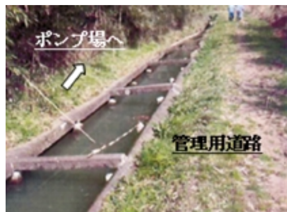
Fig. 23 湾曲部周辺での水路の閉塞（石川県提供資料） Blockage of a head race at a curved section
