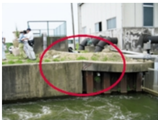
Fig. 49 矢板護岸工傘コンクリート部の損壊 (右岸側)
