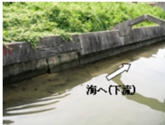
Fig. 64 大田地区での液状化による水路の被害 (コンクリート矢板の傾倒及び傘コンクリート部の破損) A canal damaged by soil liquefaction in the Ota area (Falling of concrete sheet pile and damaged upper concrete)
