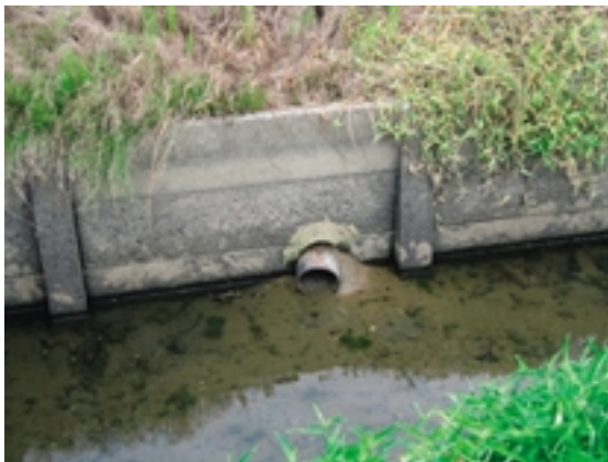
Fig. 40 暗渠周辺部からの砂の流亡 Outflow of sand around a pipe
