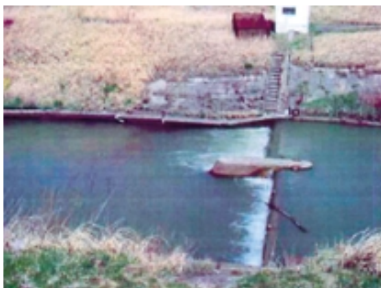
Fig. 15 頭首工護岸工の被災状況 （被災当初：石川県提供資料） View of the head work immediately after the earthquake
