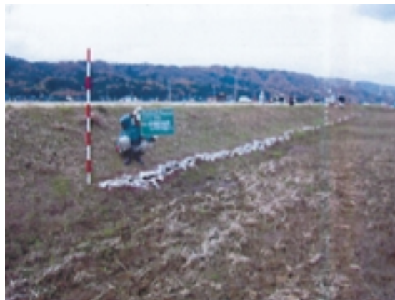
Fig. 36 水路堤防干拓地側法尻部に発生したクラック (石川県提供資料) Cracks developed at the toe of a canal bank
