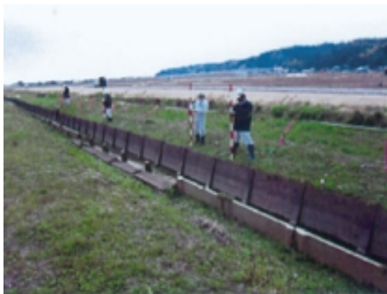
Fig. 33 断面 B 付近における干拓地側側壁の転倒 (石川県提供資料) Collapse of side panels
