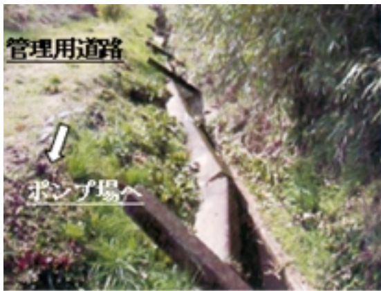
Fig. 24 水路右岸側後背部地盤の押し出しによる閉塞 (石川県提供資料) Lateral movement of backfill
