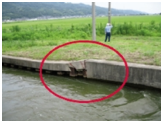
Fig. 48 矢板護岸工傘コンクリート部の損壊 (左岸側)
