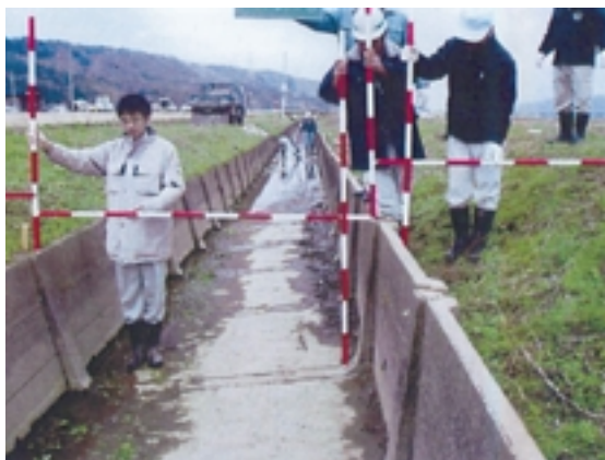
Fig. 34 断面 B 付近における水路横断方向への変状 (石川県提供資料) Cross sectional deformation of canal at section B
