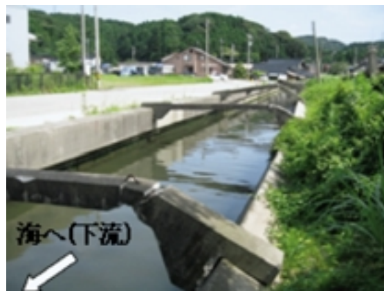
Fig. 65 大田地区での液状化による水路の被害 (切梁の破壊) A canal damaged by soil liquefaction in Ota area (collapse of struts)
