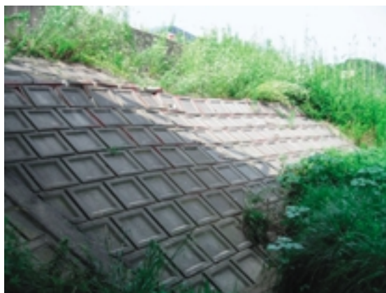
Fig. 12 頭首工直上流部（右岸）の河川護岸工の張ブロックのはらみ Projection of concrete blocks used for slope protection at the head work
