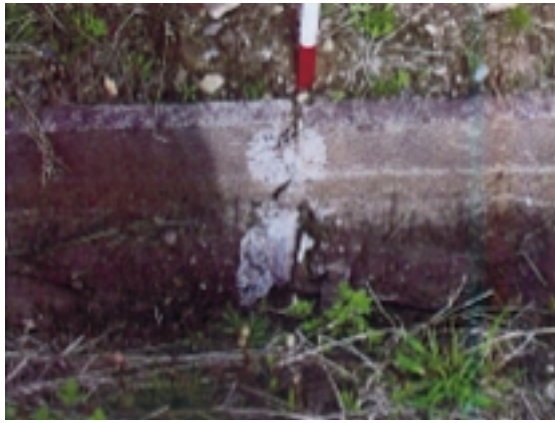
Fig. 57 幹線水路 U 字溝目地の開き（石川県提供資料） Opening of a joint between concrete flumes
