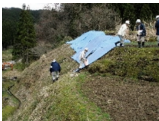
Fig.11 崖肩部のクラックへの応急対策
