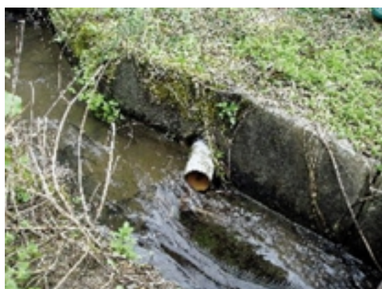
Fig.10 1号集水井排水管（地震後排水無し）
