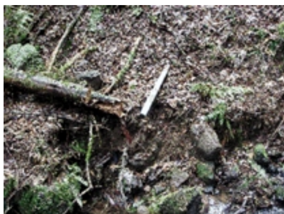
Fig.9 3号集水井排水管（地震後排水無し）
