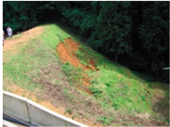
Fig.18 崩壊後の状況 (2007 年 8 月 7 日) Down slope failure
