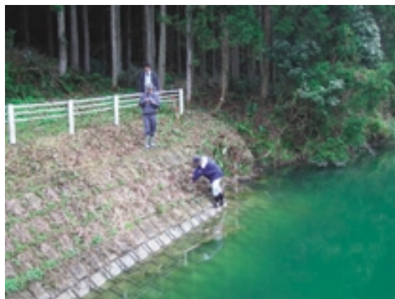
Fig.11 上流右岸地山部の吸い込み部分（想定） Inlet position of reservoir
