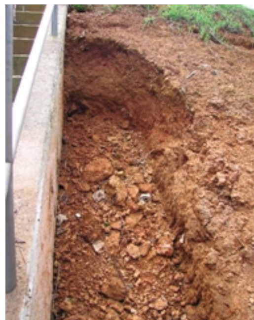
Fig.20 すべり部 (2007 年 8 月 7 日) (銭茂谷内池) Slip failure of the slope at the inlet work
