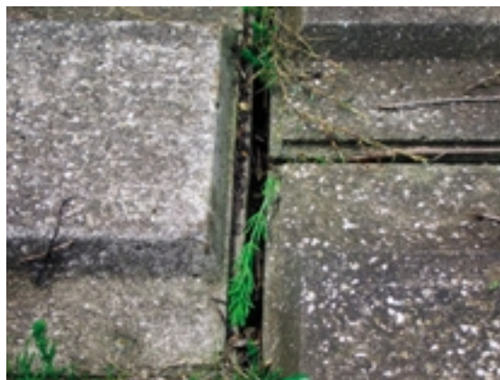
Fig.13 保護ブロックのズレ（右岸部） Open crack in the concrete block mat
