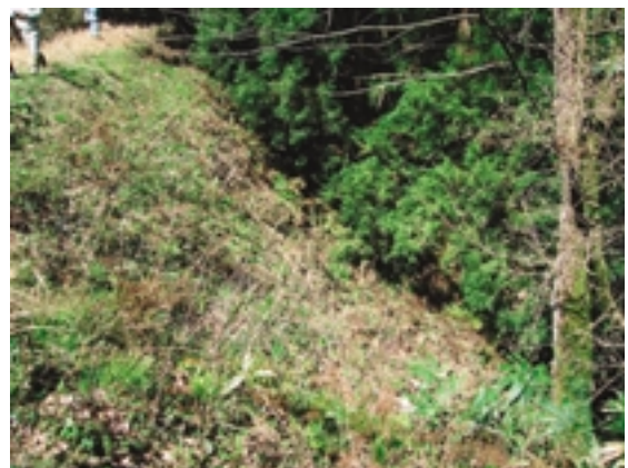
Fig.24 下流斜面部（一部に崩壊がある、牛谷池） View of the down stream slope
