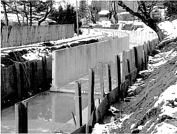
Photo 25 フルームによる本格復旧 Restoration works with concrete flume canals
