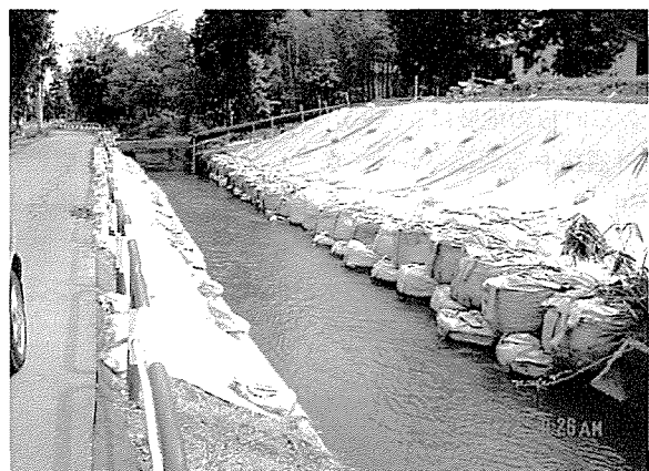
Photo 24 土嚢による応急復旧 Urgent repair of canals with soilbags
