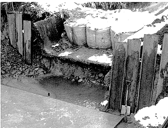
Photo 21 取り壊し中の水路断面
