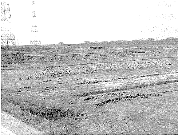
Photo 14 岩野地区の状況 A view of Iwano area
