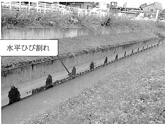
Photo 8 1号幹線水路(三洋電子前)
