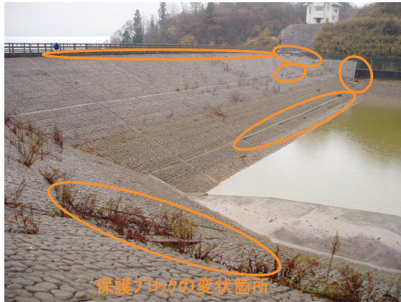
Photo 7 太田ダムの上流斜面の状況（全景）
