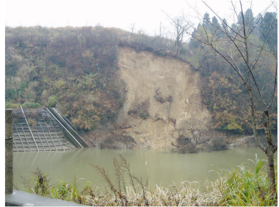
Photo 10 池敷地山斜面の崩壊
