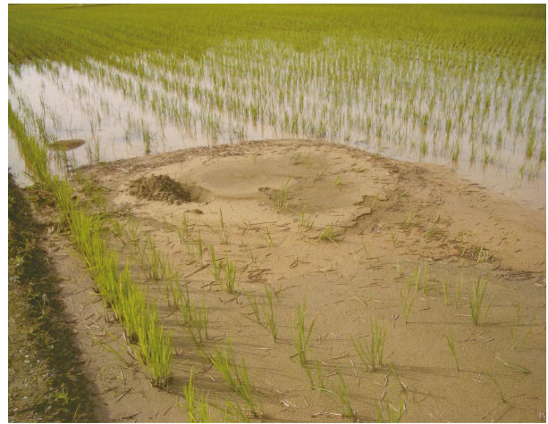
Fig.22 水田における液状化による土砂の噴出（04.10） Sand gushing on field by the liquefaction
