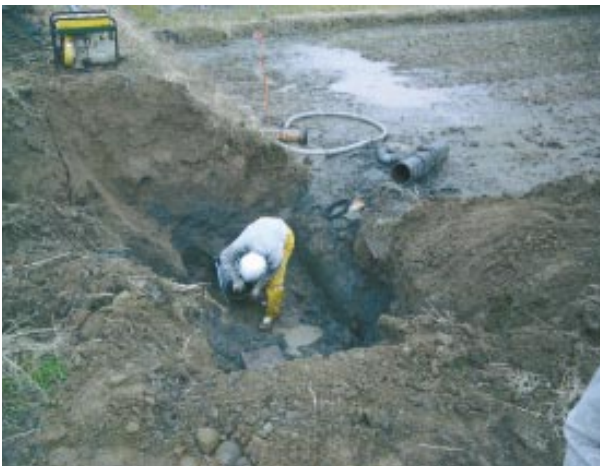
Fig.31 パイプライン復旧状況(04.12) A Repairing affair in pipeline
