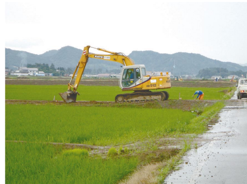
Fig.22 水田畦畔の復旧工事 (旧淡路町岩野, 2005.7.4撮影) Recovery construction of paddy field levee
