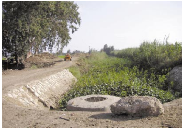
Fig. 9 デリバリキャナルのテイルエンド (tail end) (バハル・ヌール) Tail end of delivery canal (Bahr El Nour)
