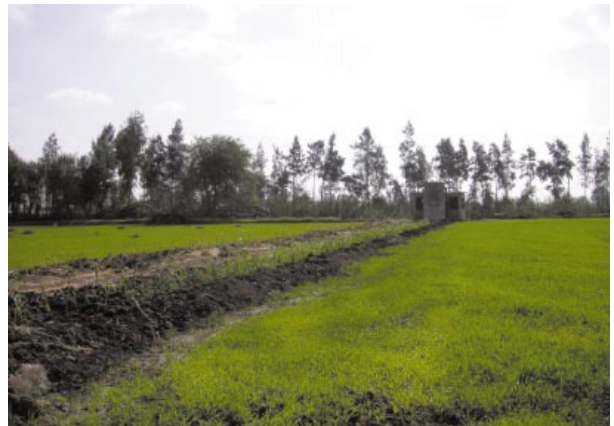
Fig. 11 改良工事中のパイプラインメスカ (バハル・ヌール) Improving meska with pipe line (Bahr El Nour)
