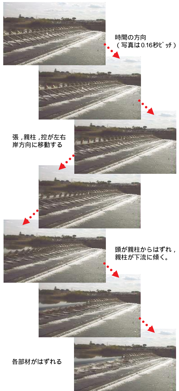
Fig. 22 板羽目堰の開放の様子 The state of Itabame weir release
