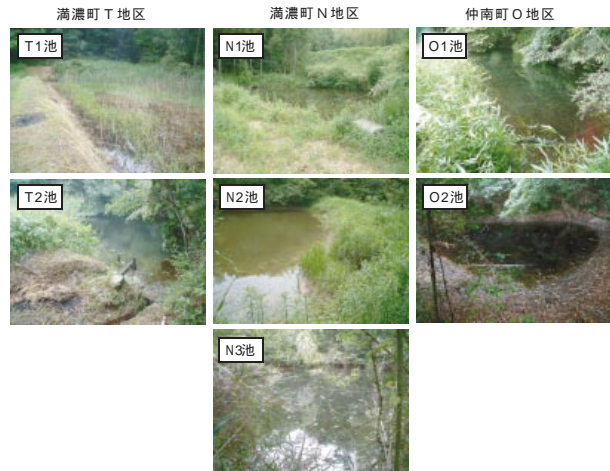
Fig.4 調査ため池の状況 (2003年6月時) Situation of investigation pond (Jun, 2003)
