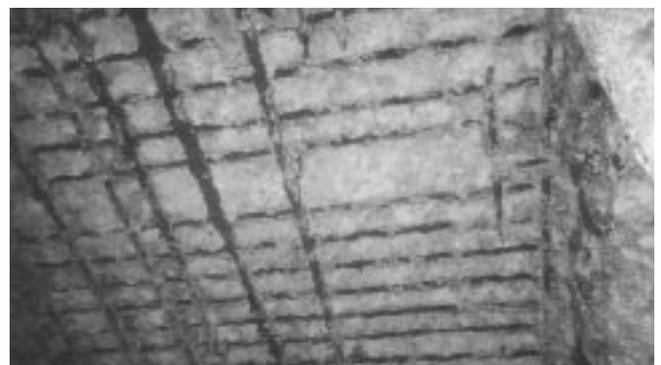
Fig.6 化学的腐食を受けた下水道施設の例
