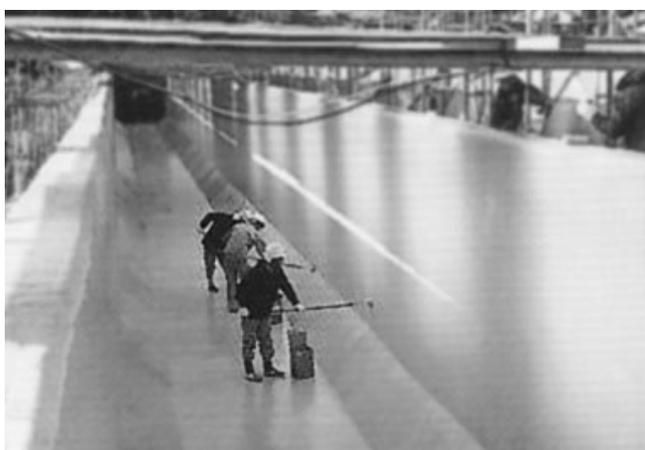
Fig.10 表面被覆工法（塗装工法）の例
