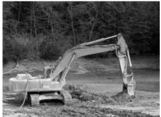
Photo 3 トレンチャー式攪拌混合機による原位置初期固化状況の例 Example of in-situ initial stabilization by trencher-type mixing machine
